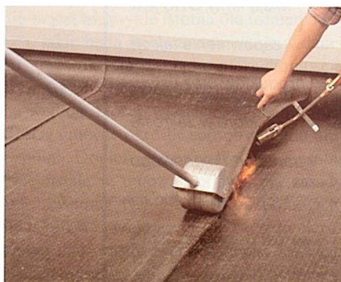
Zgrzewanie i dociskanie zakładów
